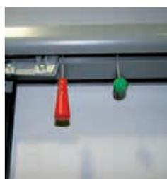
Débrayage manuel du moteur à l'intérieur du garage en cas de panne de courant
