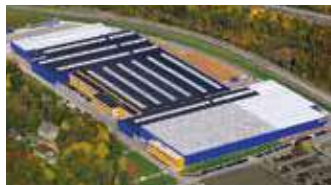
Hörmann KG Eckelhausen, Allemagne
